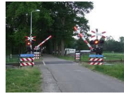
Beveiligde overweg تقاطع خط راه آهن با جاده همراه با تیرک مانع
